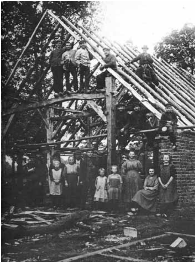
Der Arbeitsplatz der Zimmerleute war der Bauplatz. Dachkonstruktionen wurden noch ohne Kran errichtet. Foto: Stadtarchiv
