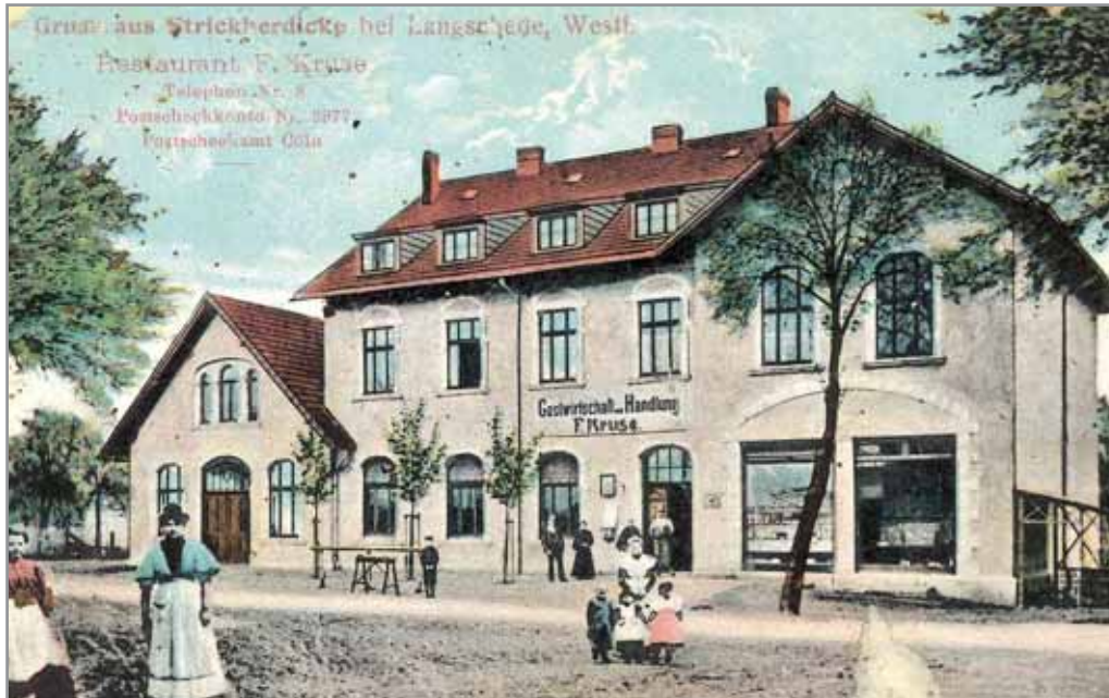
Das Gebäude an der B233 erkennt man noch - Nutzung und Eigentümer haben gewechselt.
